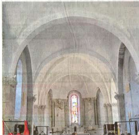
Les voûtes de la nef et du transept ont été entièrement refaites.
